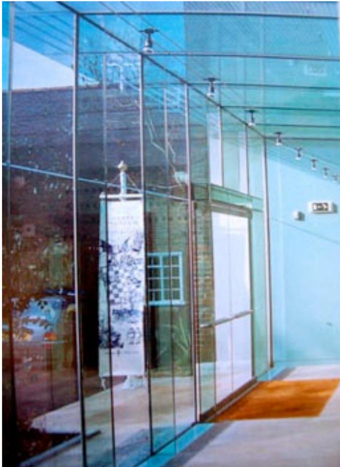
I **vetri termocromici** variano l'assorbimento della radiazione luminosa in funzione della temperatura superficiale esterna: si opacizzano quando si raggiunge una temperatura alta e ritornano trasparenti nel momento in cui si abbassa nuovamente. Un punto critico di questo sistema è determinato da una diminuzione di guadagni solari nel periodo invernale.
