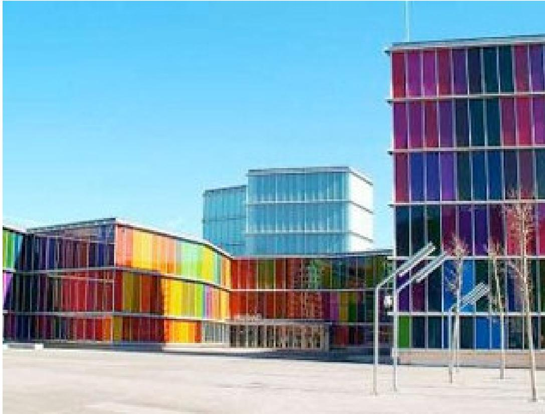
I **vetri colorati** ottenuti con aggiunte di sostanze coloranti al vetro fuso, hanno molta importanza legata al controllo della luce e a quello dell'energia termica.
